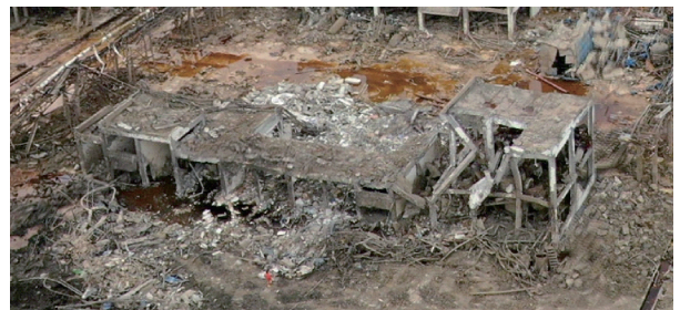
图10 建筑物 A 破坏情况
